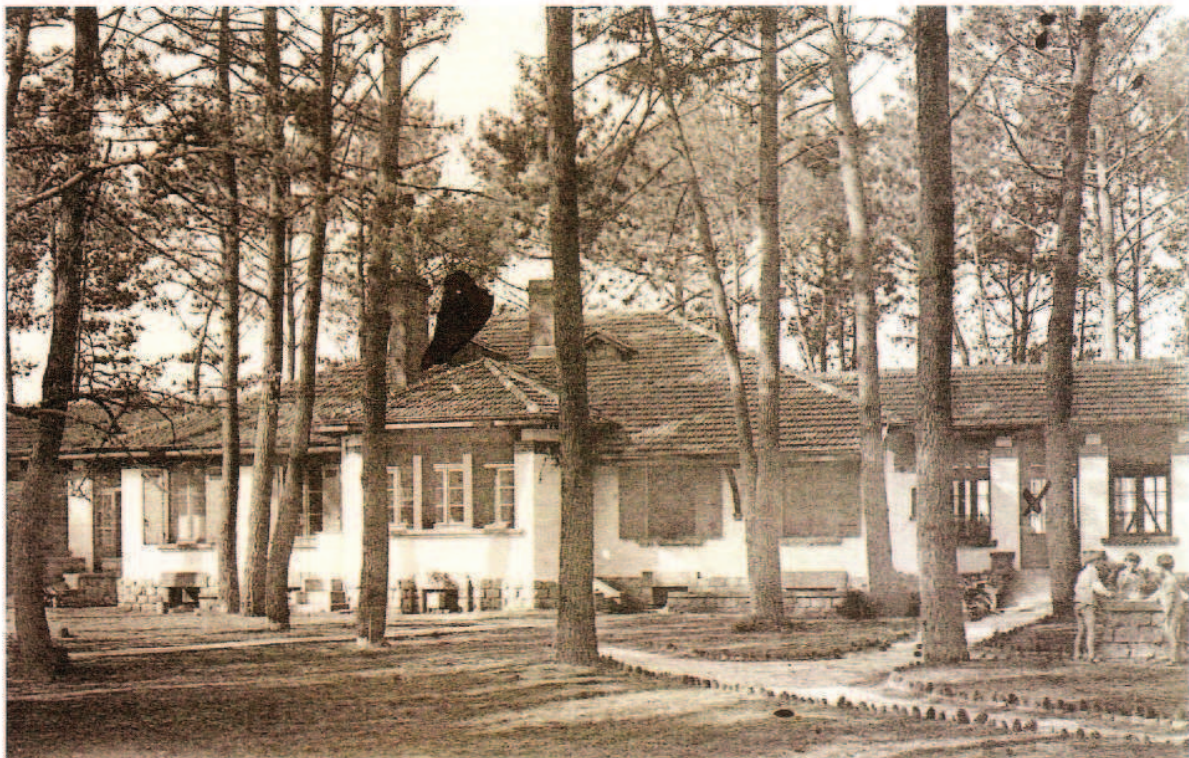
2. AÉRIUM DE LA FONDATION WALLERSTEIN 1913, à Arès (Gironde) — Cour intérieure, 19
